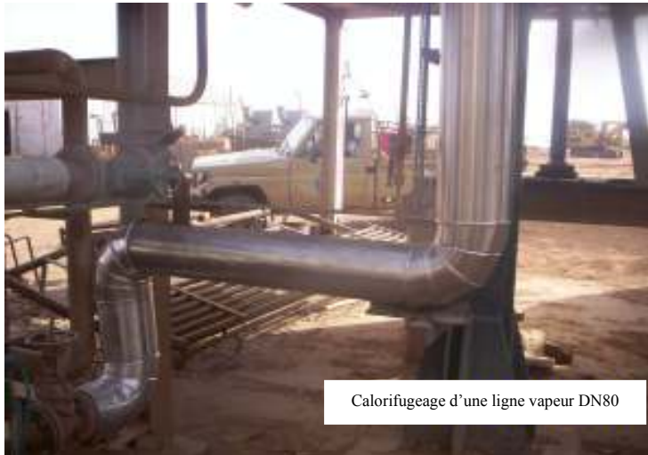
Calorifugeage d'une ligne vapeur DN80 usine Somair-Arlit
